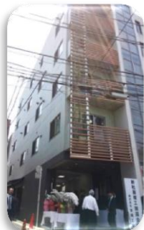
完成した藤本ビル
